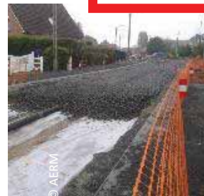
Voirie à structure réservoir
