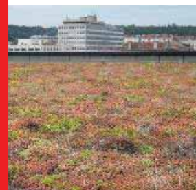
Toiture végétalisée (min. 8 cm d'épaisseur)
